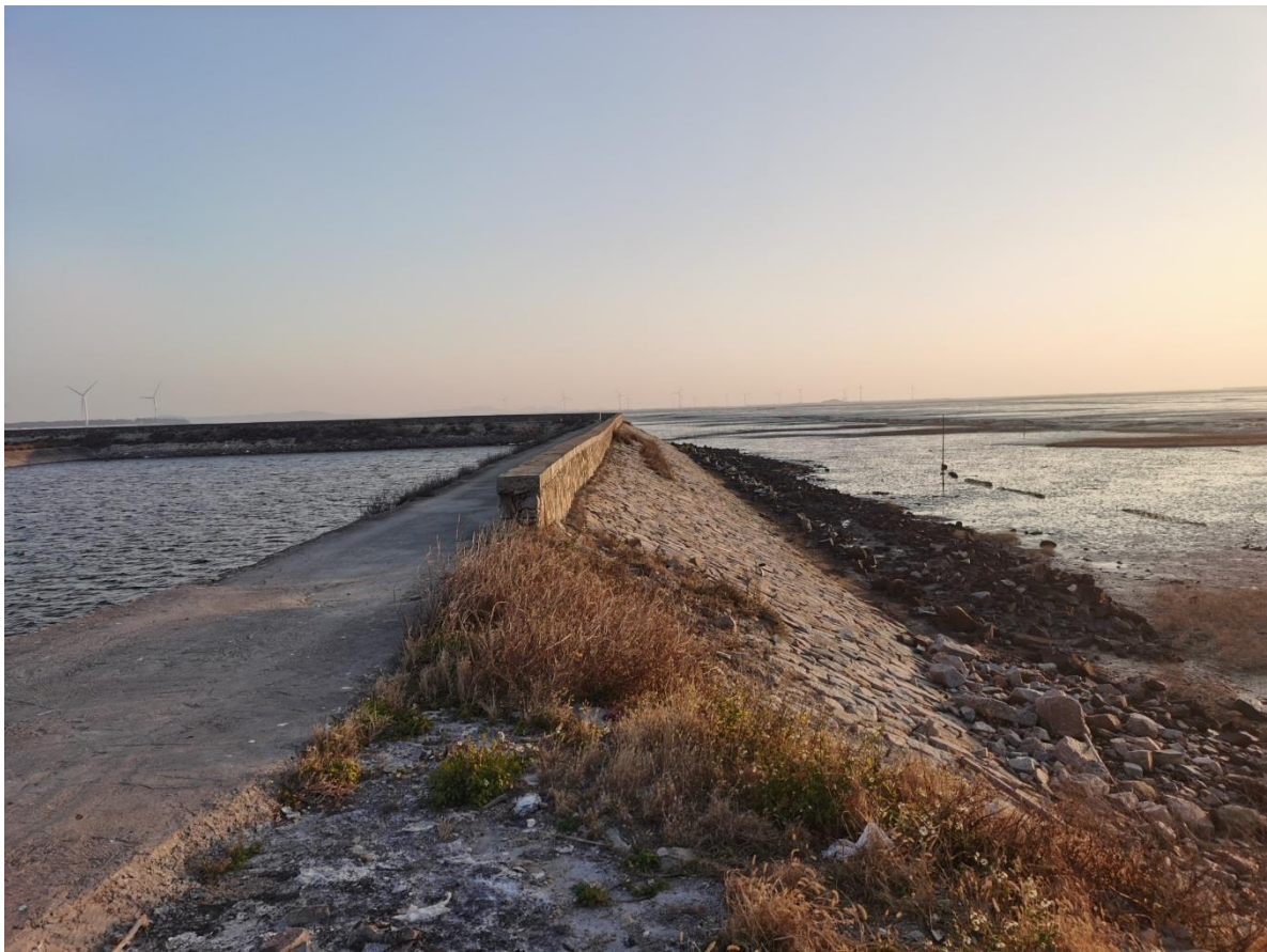
图 2.2-4 围堤结构现场照片
