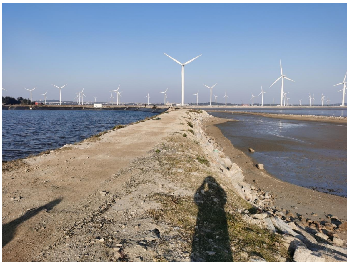
图 2.2-3 塘埂边坡现场照片
