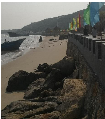
项目区护岸现状（南侧）
