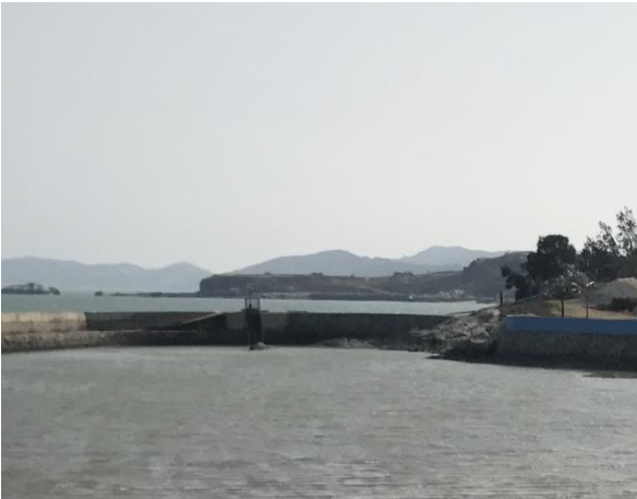
底播贝类休闲养殖区水闸 图5.3-2 项目区内现状
