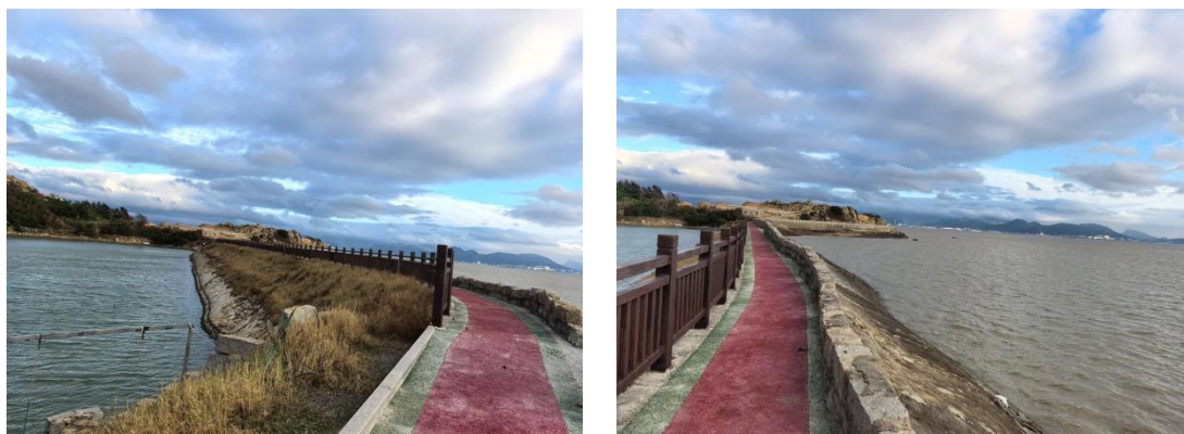
照片 2.2-1 外侧围堤照片
