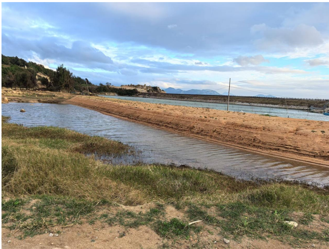
照片 2.2-2 内侧围堤照片
