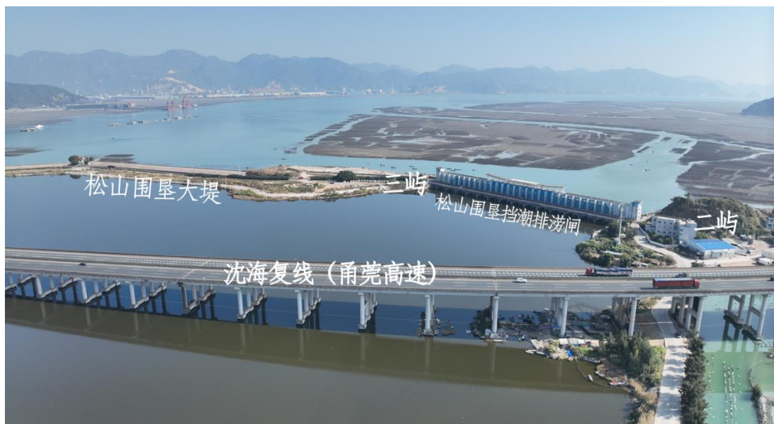
图 2.2-4 松山围垦挡潮排涝闸工程现状照片
