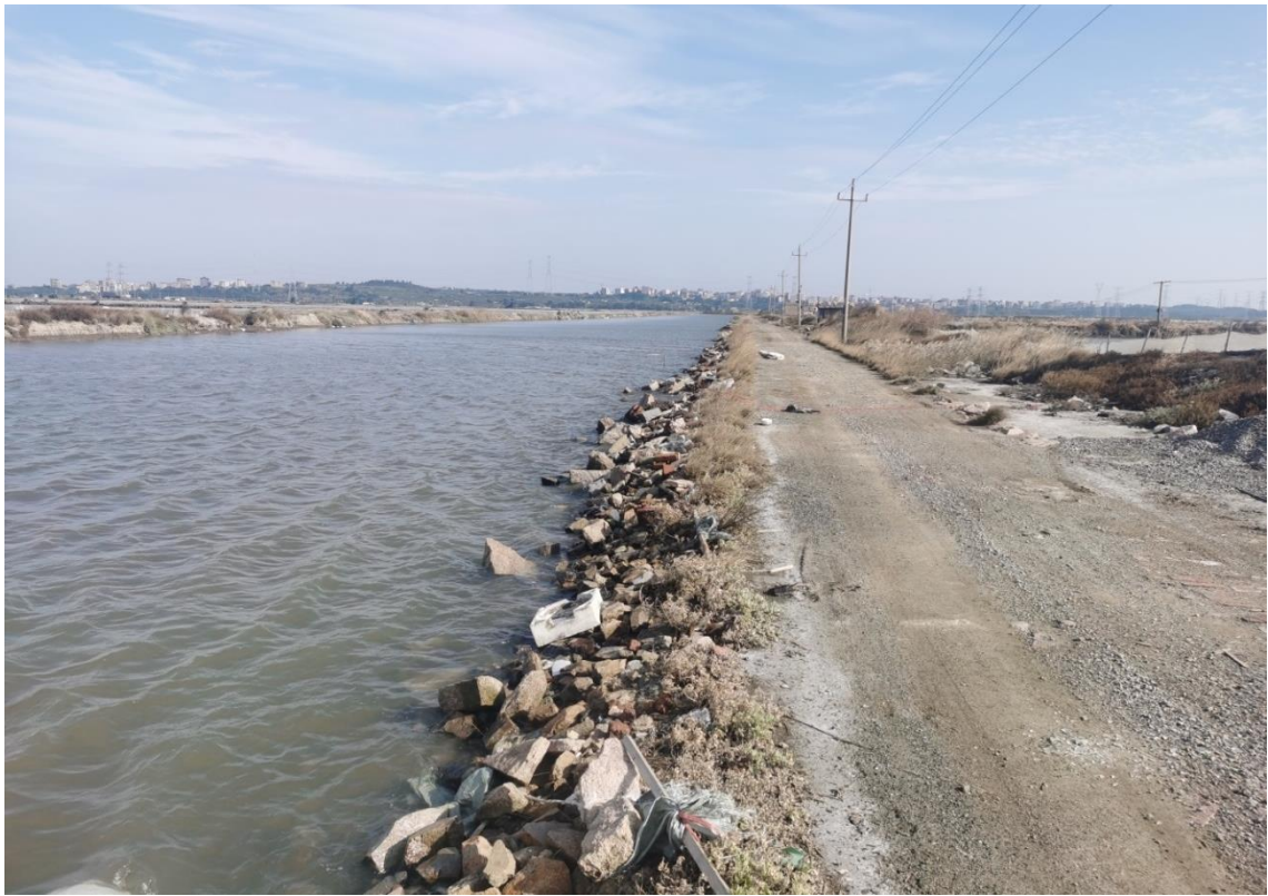
图 2.2-3 塘埂边坡现场照片 1
