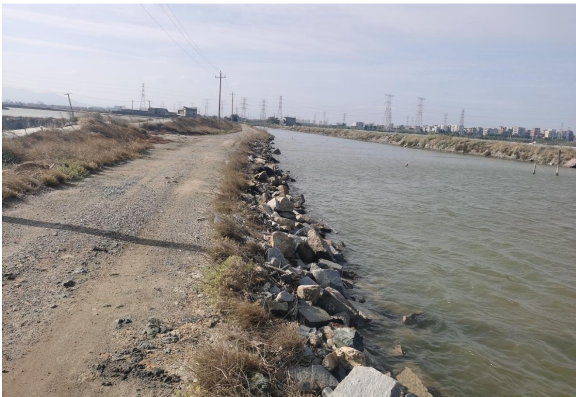
图 2.2-4 塘埂边坡现场照片 2
