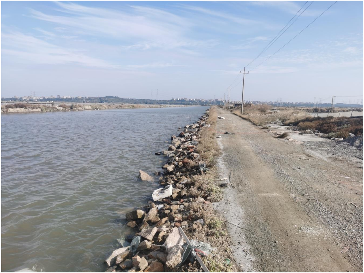
图 2.2-3 塘埂边坡现场照片 1
