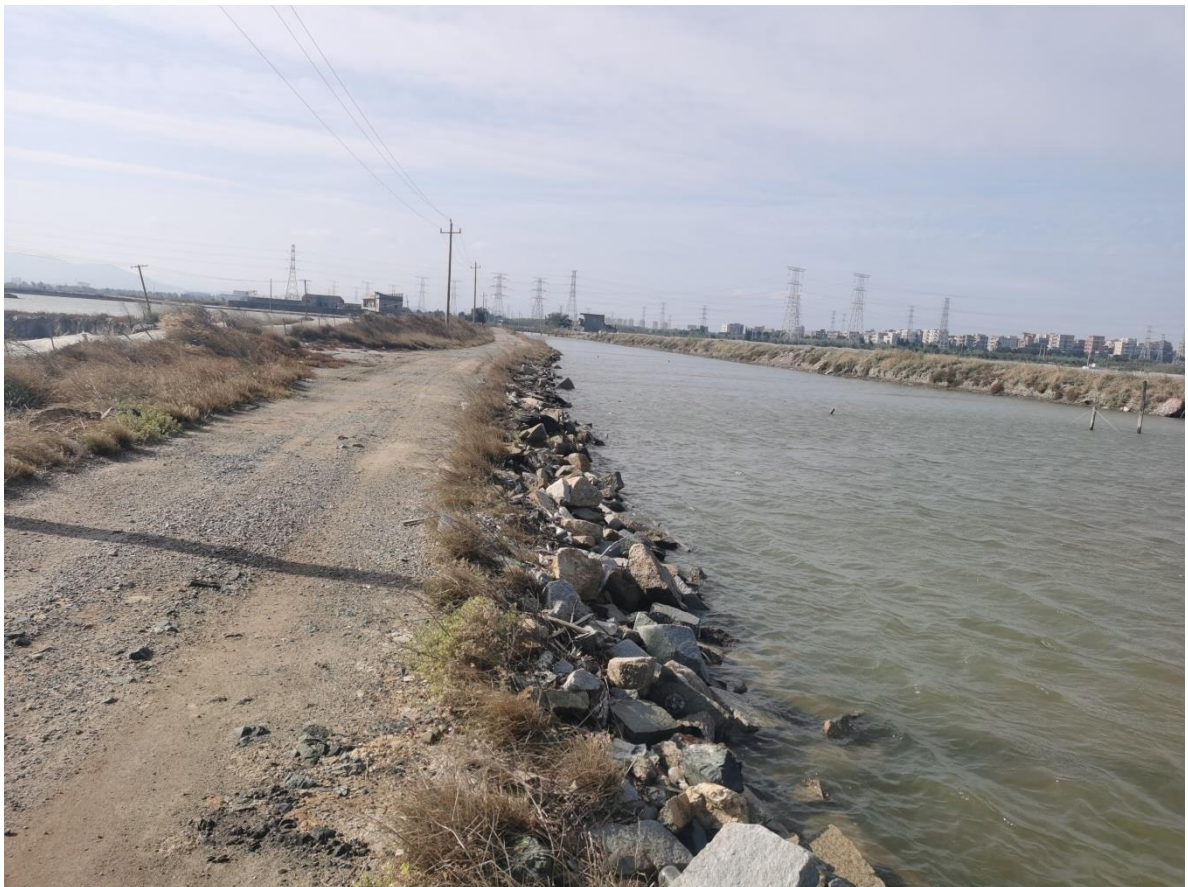
图 2.2-4 塘埂边坡现场照片 2
